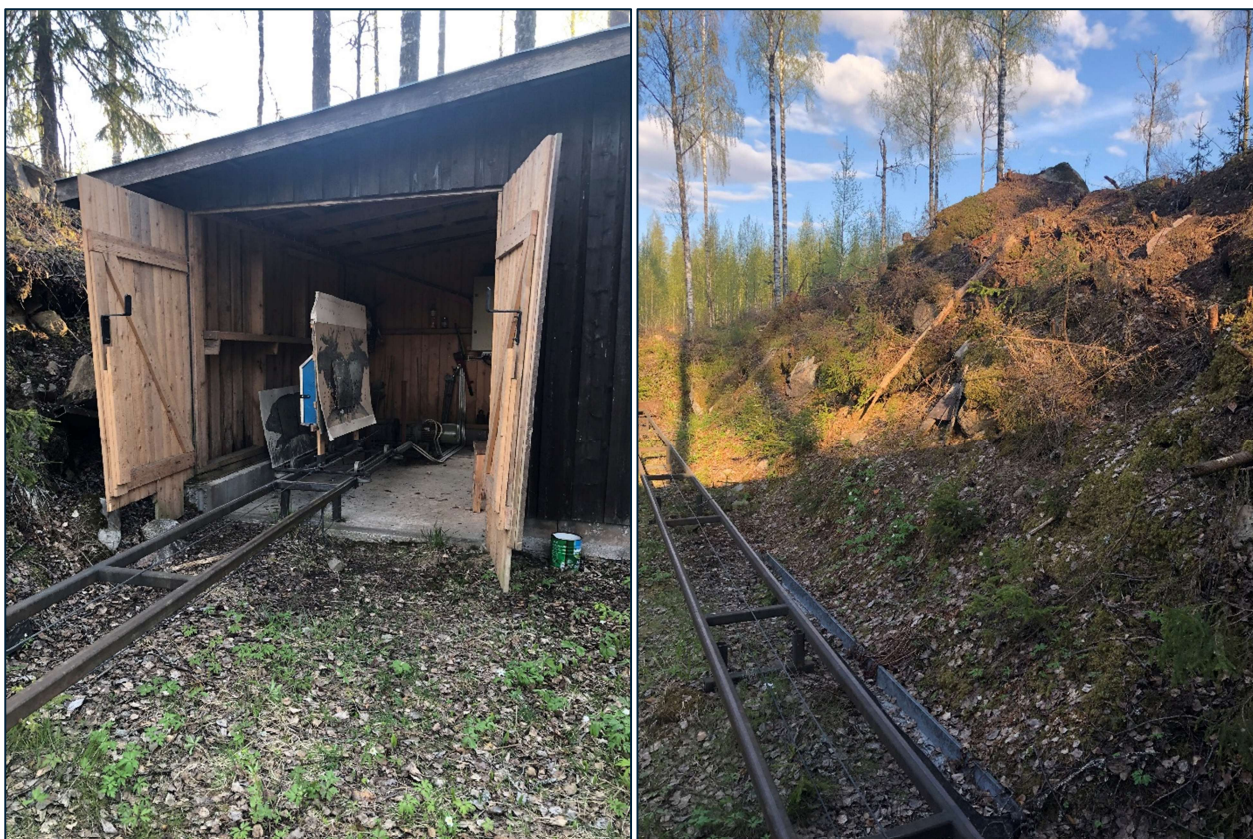
Kuva 10. Maalialueen suojakoppi ratalaitteille ja taustapenkki. (Kuva: Veli-Matti Nurminen.)
